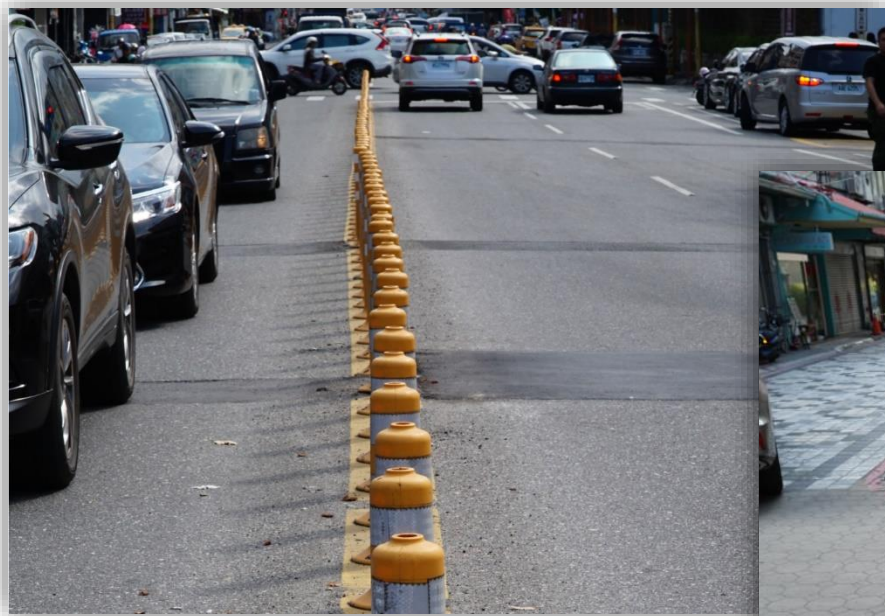
◀中正路麥當勞前之路面錯動。黑色柏油即 2016 年 2 月的地表破裂位置
