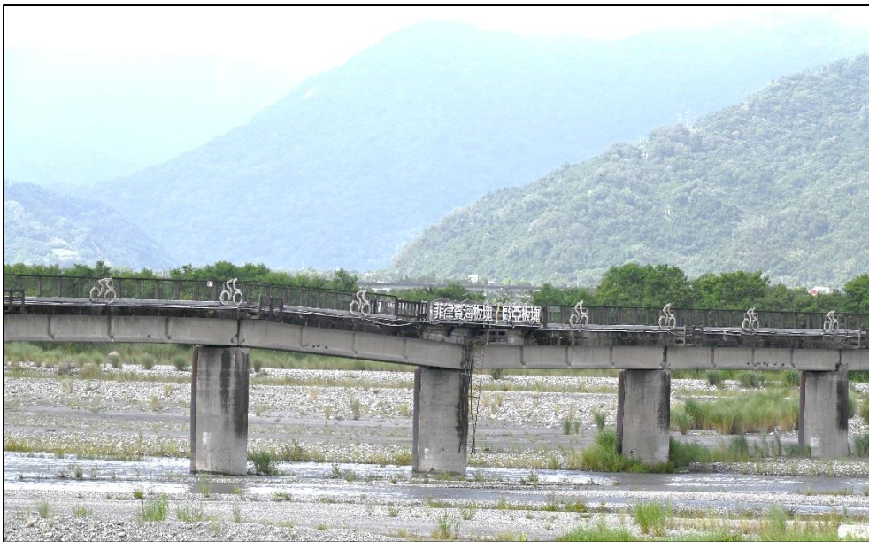
◀秀姑巒溪上之歐亞板塊及菲律賓海板塊交界紀念碑，橋面變形顯示跨越池上斷層之壓縮作用與無震變形。
