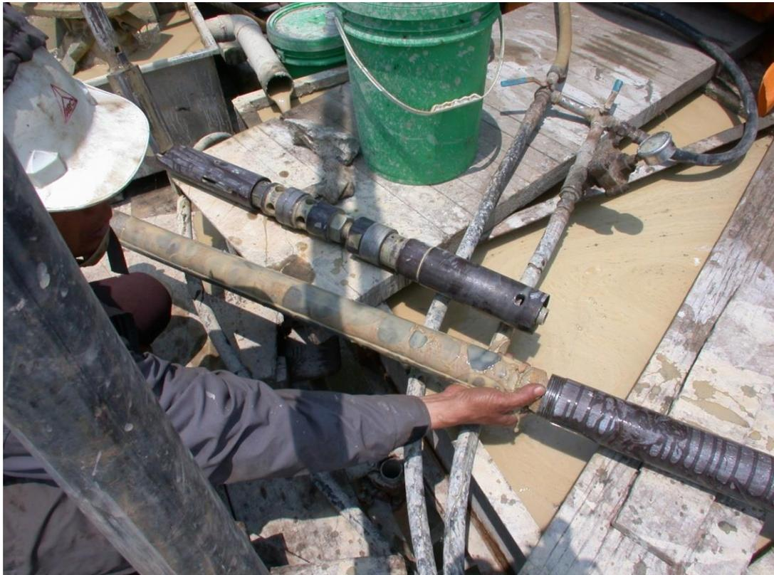
圖 5. 桃園市觀音區大堀溪出海口南側潮間帶較深鑽孔作業，剛從岩心管取出的古石門沖積扇礫岩。
